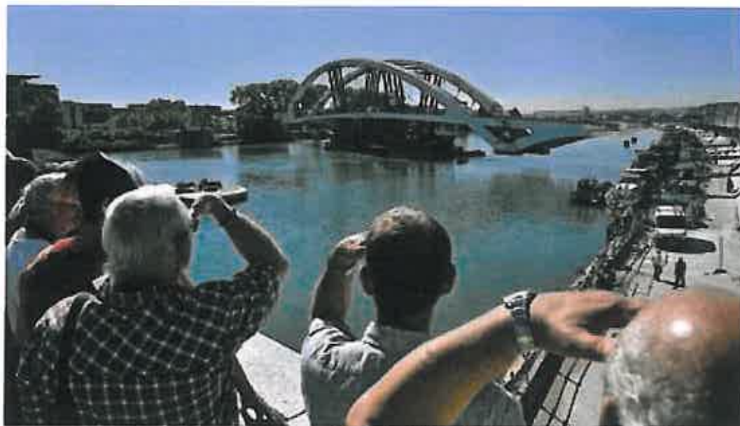
Les collectivités s'inquiètent de devoir être obligées de tailler dans les investissements. Ci-dessus, l'installation à Lyon du pont Raymond-Barre en septembre dernier. Photo Romain Lafabregue/AFP
